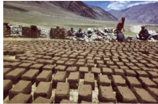
Lehmziegel-Herstellung in der SECPAD-Anlage
